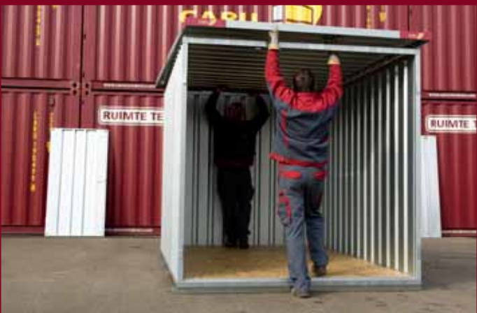
Plaats het dak
