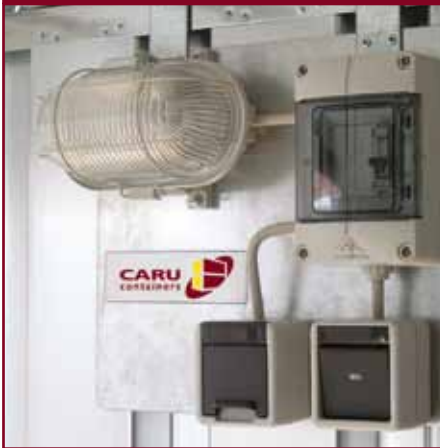
Elektra pakket (220V)
