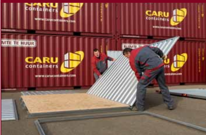
Plaats de zijwanden
